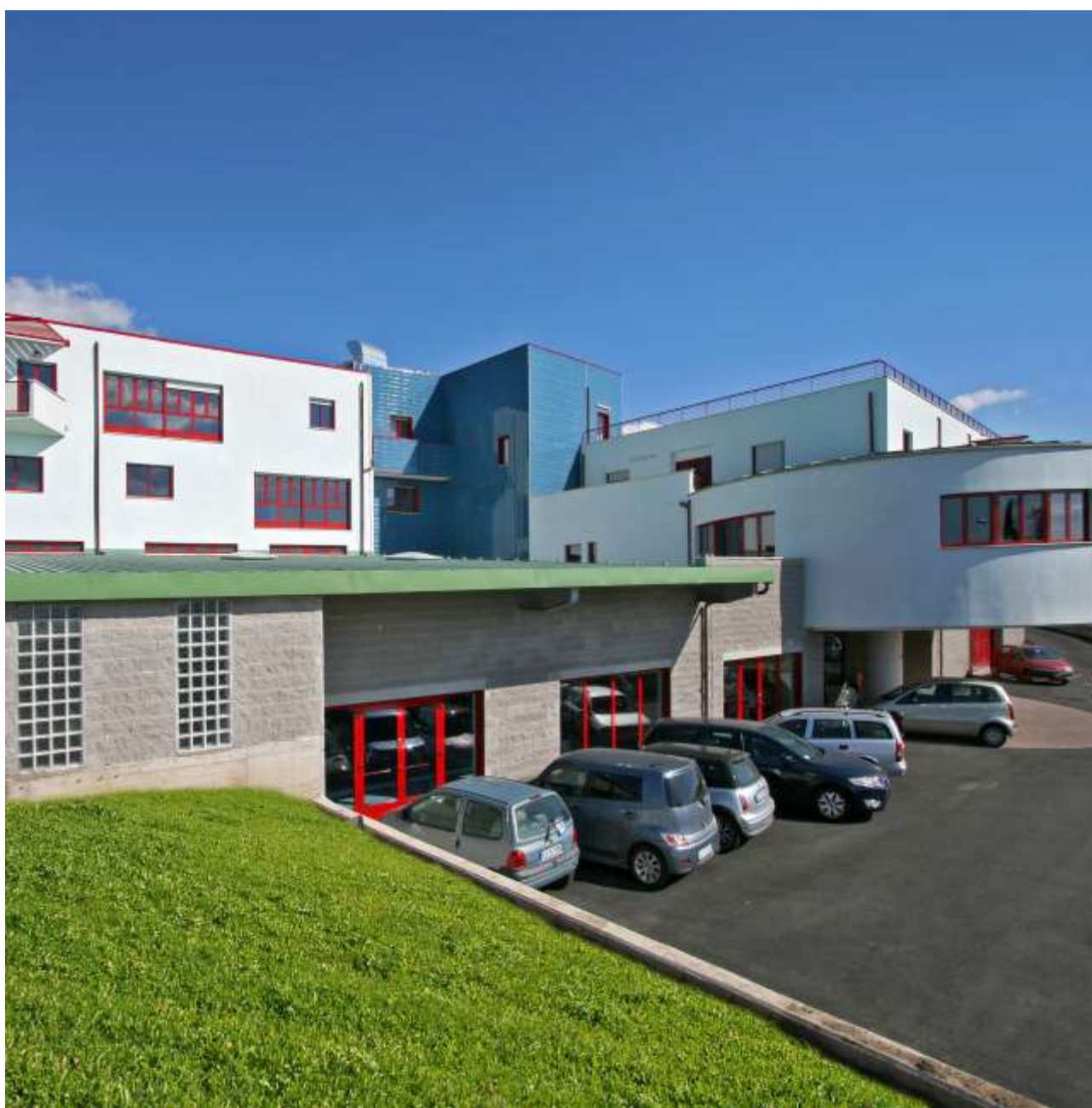
RESIDENZA SANITARIA ASSISTITA "IL TETTO" E RELATIVA PISCINA
